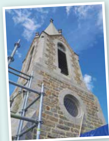
Le clocher après rénovation
