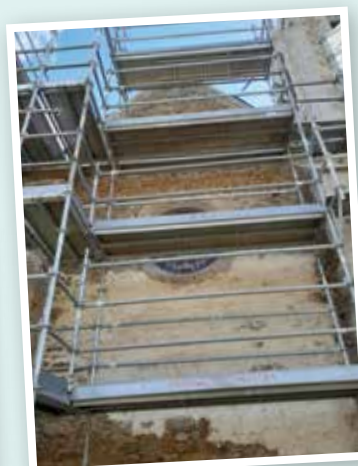
Enduits extérieurs à venir
