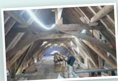
Reprise de la charpente
