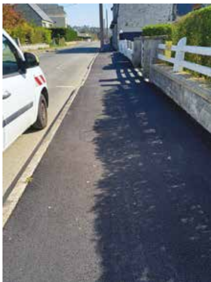
Réfection du trottoir Rue du Chêne Vert
