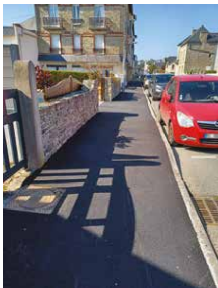
Réfection du trottoir Boulevard Duponchel
